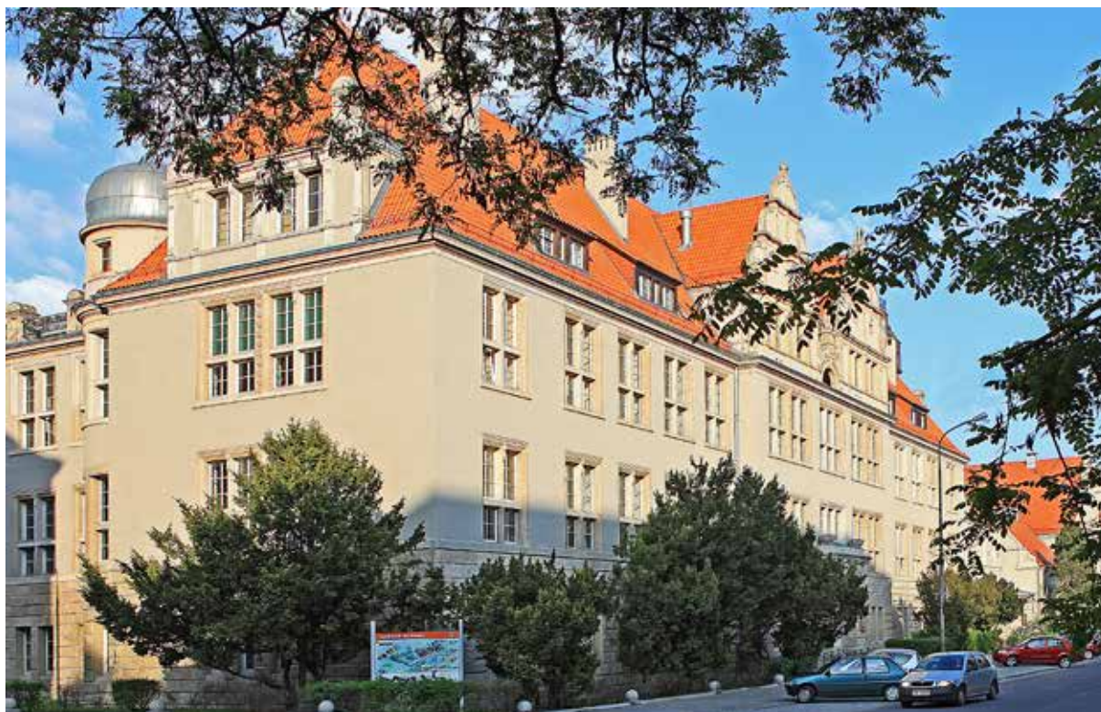
Ilustracja 7. Budynek Wydziału Chemicznego, tzw. Stara Chemia (A-3)
