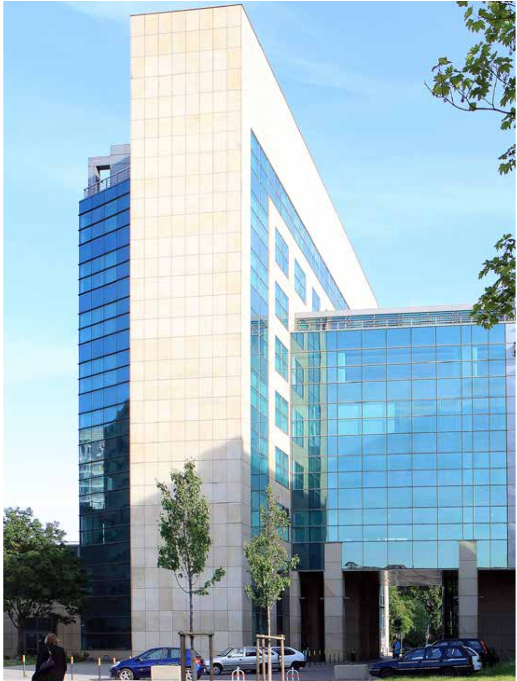
Ilustracja 13. Gmach Centrum Naukowo-Badawczego Wydziału Elektrycznego (D-20) od strony północnej
