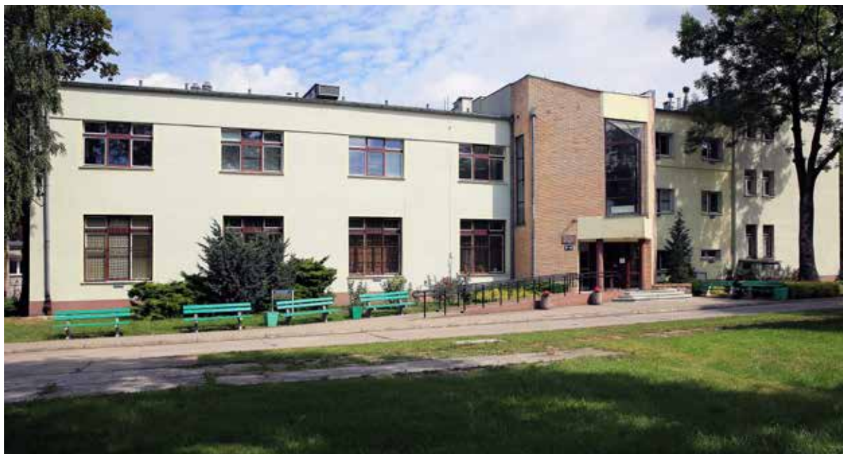
Ilustracja 22. Budynek Wydziału Chemicznego i Archiwum Politechniki Wrocławskiej (F-4)
