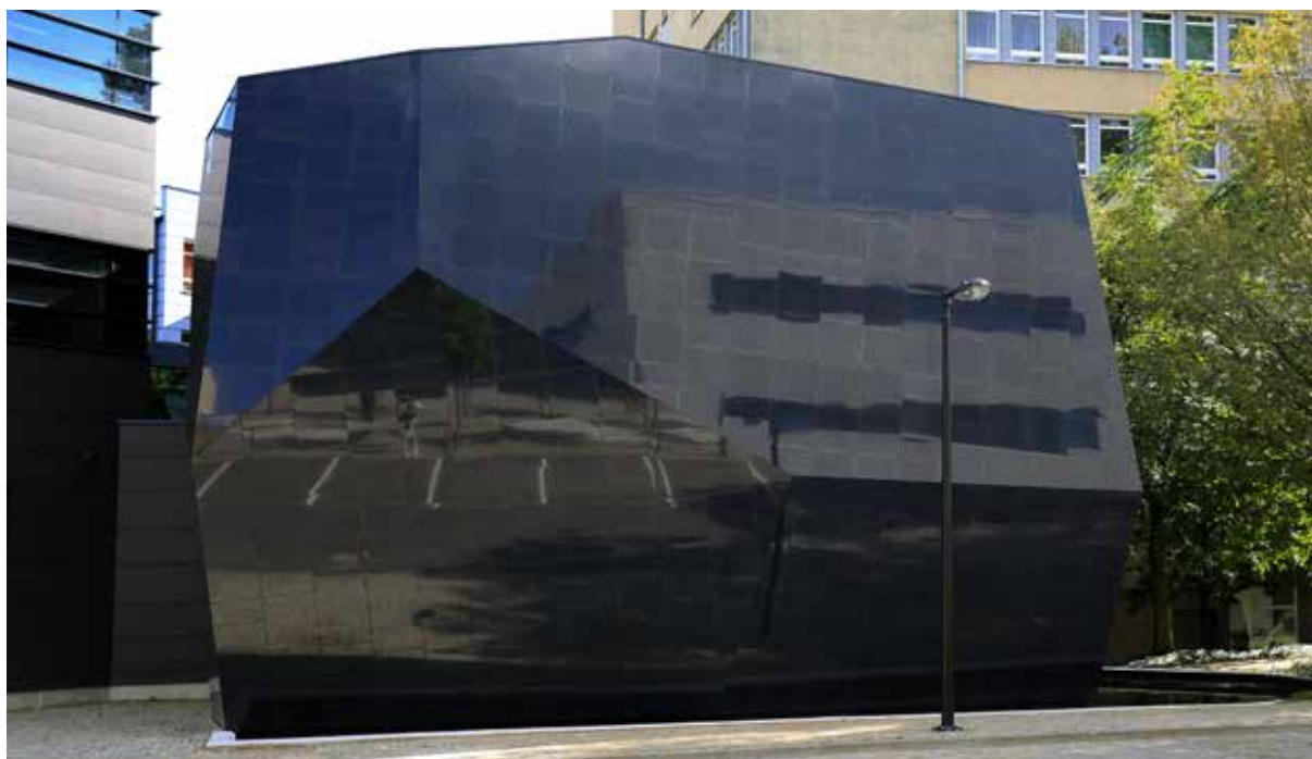
Ilustracja 46. Komora akustyczna – architektoniczny aneks do budynku C-16
