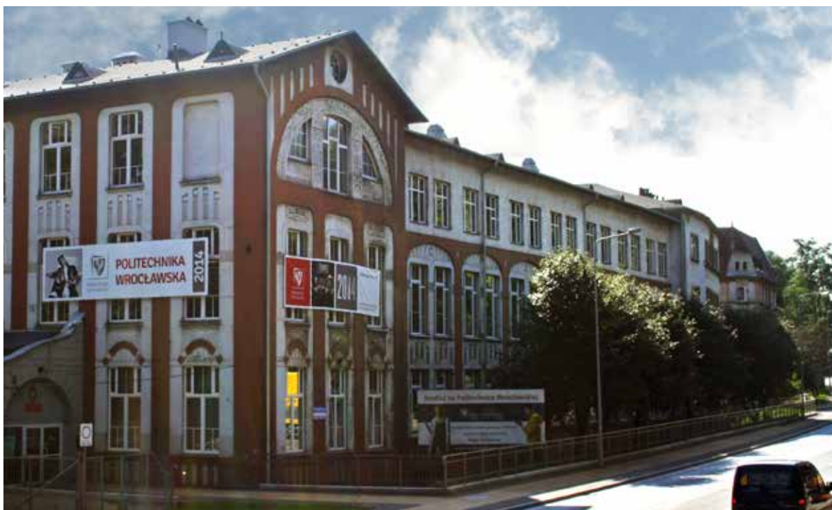
Ilustracja 32. Główny budynek Wydziału Techniczno-Inżynierskiego w Wałbrzychu
