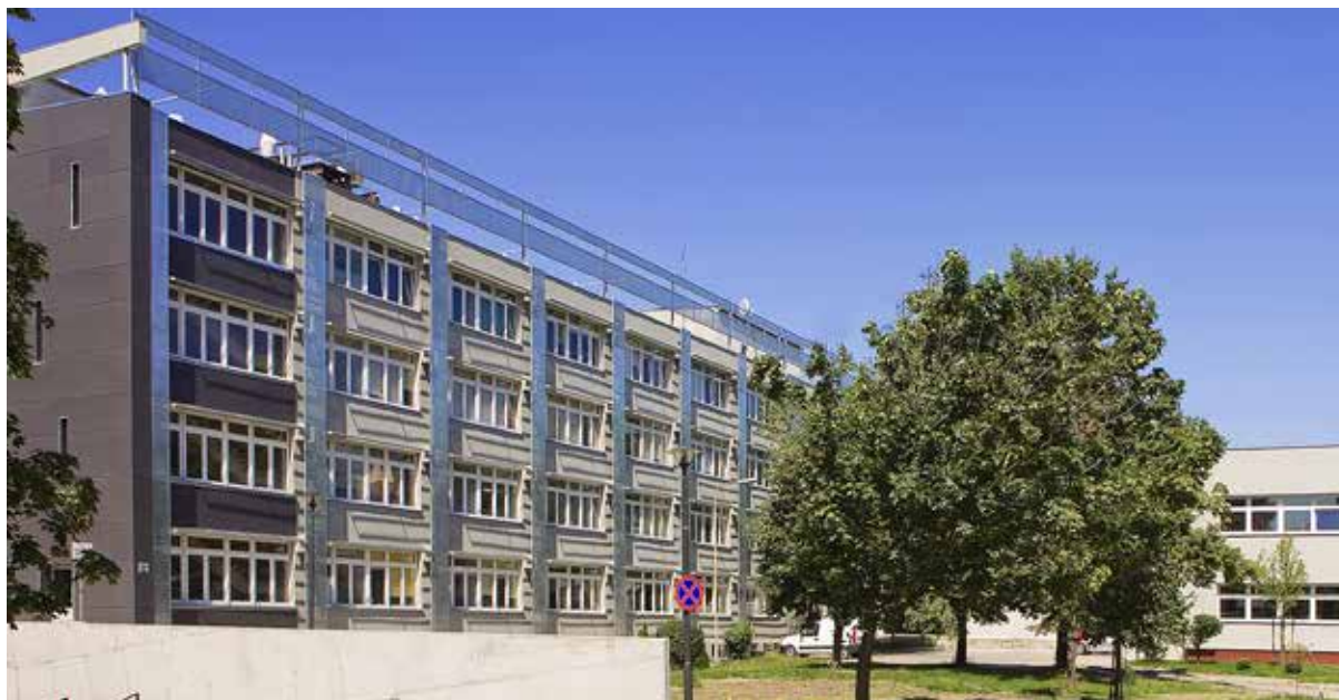
Ilustracja 48. Budynek dydaktyczno-laboratoryjny Wydziału Chemicznego (C-6)
