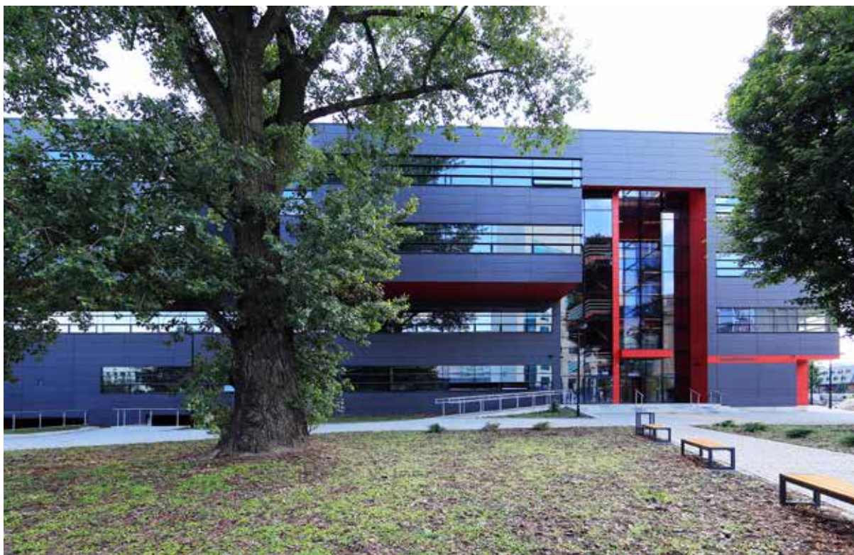
Ilustracja 20. Gmach Centrum Zaawansowanych Technik Informatycznych i Komunikacyjnych (Technopolis I, C-16)
