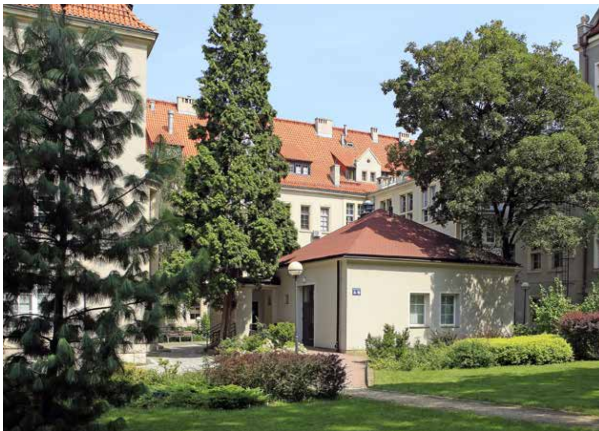
Ilustracja 39. Siedziba Laboratorium Badań Strukturalnych Wydziału Chemicznego (A-9)
