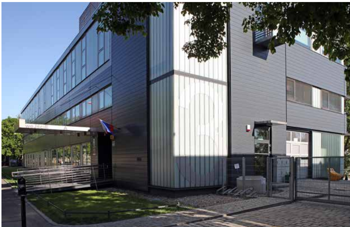
Ilustracja 37. Budynek Instytutu Inżynierii Lądowej (H-3)
