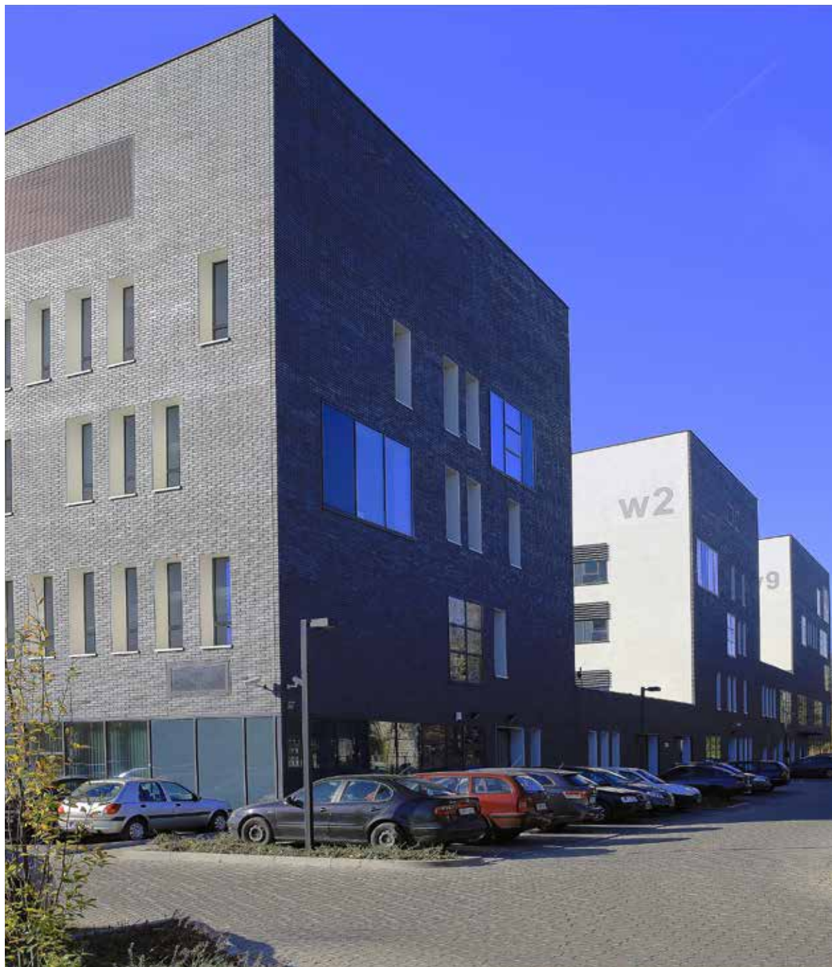
Ilustracja 26. Gmach Geocentrum I (L-1) – widok od północnego wschodu
