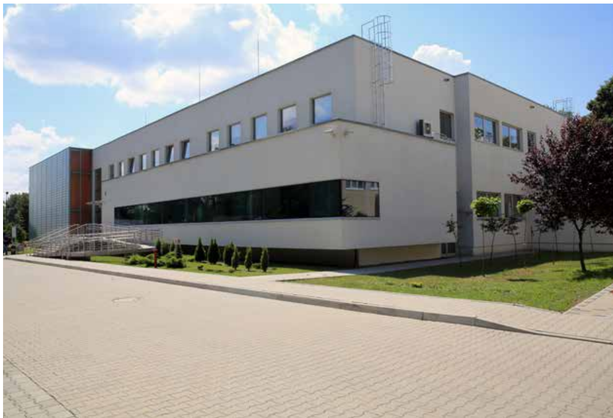
Ilustracja 25. Gmach Centrum Edukacyjno-Technologicznego (Technopolis II, M-11) od strony części laboratoryjnej
