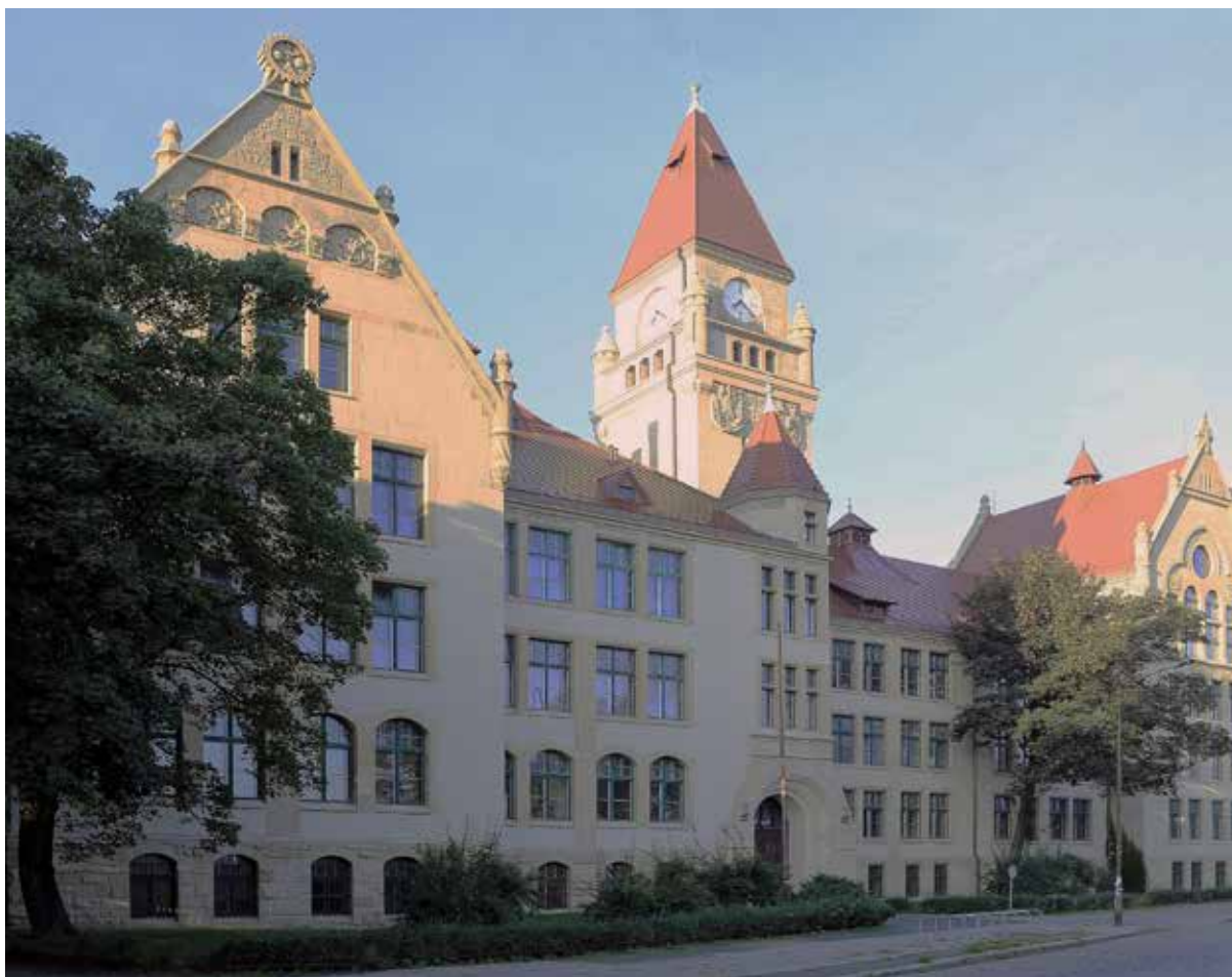
Ilustracja 23. Gmach Wydziału Architektury (E-1)
