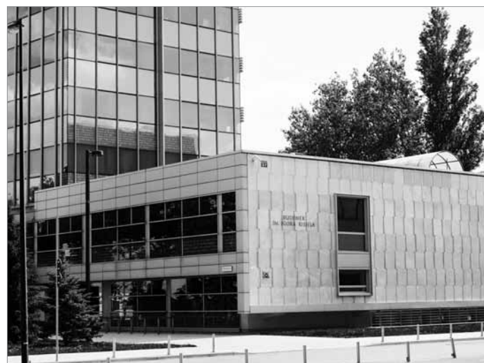
Ilustracja 19. Fragment gmachu Wydziału Budownictwa Lądowego i Wodnego (C-7)
